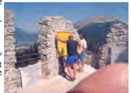
Remplacement de s panneaux: Historique des Troupes de Montagne
